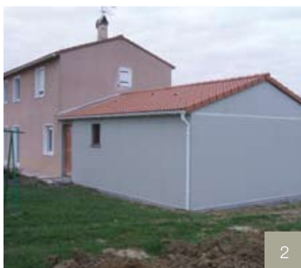
1/ Mise en place de la charpente métallique - 2/ Mise en place de panneaux isolants - 3/ Pose nouvelles menuiseries et couverture
