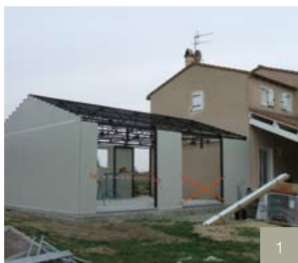
1/ Mise en place de la charpente métallique - 2/ Mise en place de panneaux isolants - 3/ Pose nouvelles menuiseries et couverture
