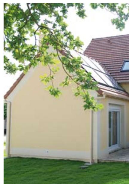
Maison après travaux
